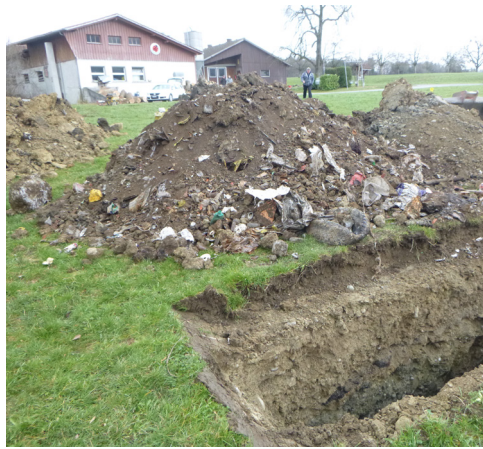
Typischer Aushub einer ehemaligen Kehrichtdeponie (Foto: Ingenias AG)
