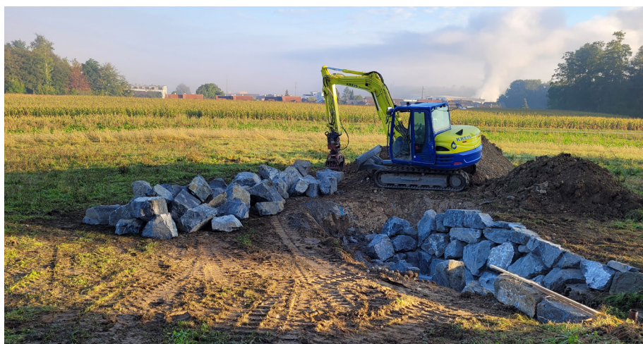
Baulicher Unterhalt eines Gemeindegewässers (Foto: Ingenias AG)
